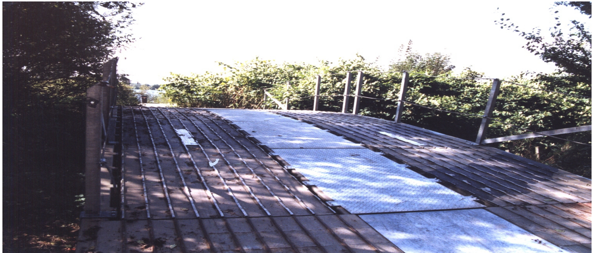
Behelfsbrücke VICKERS mit Tränenblech-Mittelabdeckung und Seilgeländer
