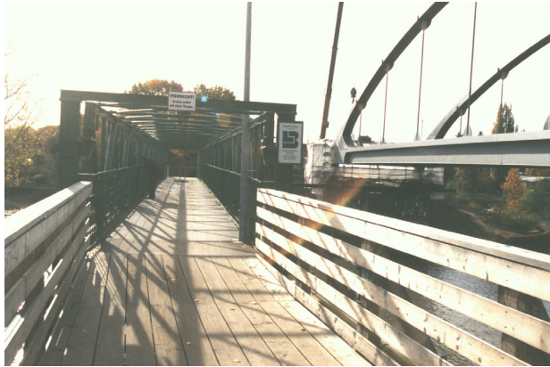
FB-42/2,5 Behelfsbrücke über den Mittellandkanal in Hannover – L= 36,00m
